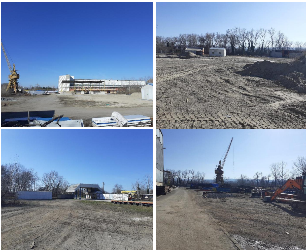
Слике бр. 6-9: Фотографије локације планиране за постављање мобилне фабрике бетона унутар комплекса Бродоградилшта Нови Сад (фото: фебруар 2024. год.)
